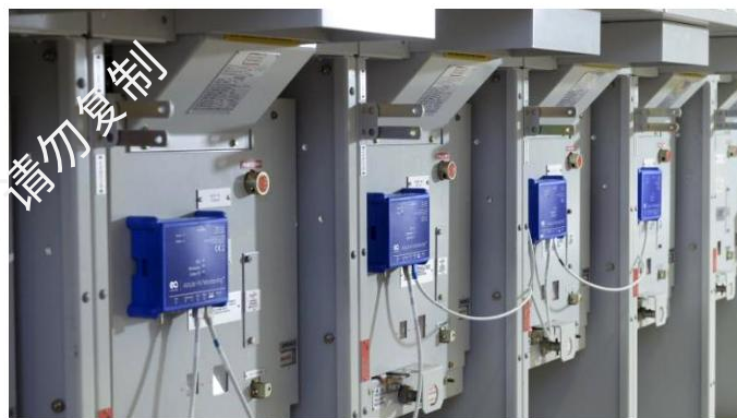
中石化海南炼化机动配电在线监测系统
