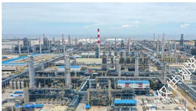
中石油广东石化炼化厂信息化建设
