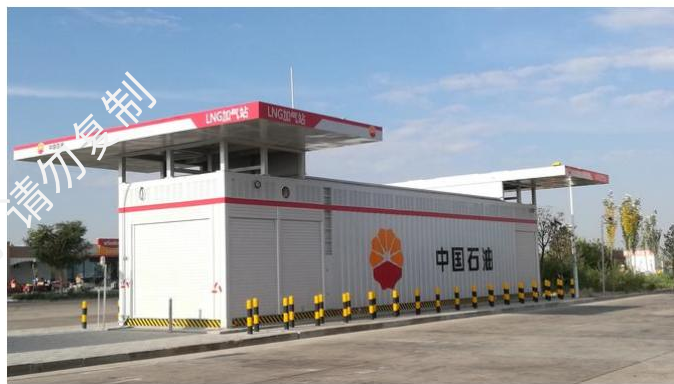
中油深南天然气库站电气设施预防性试验
